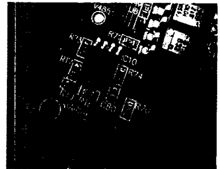
TARJETA(S) ELECTRÓNICA(S) DETERIORADO (Elemento de estado solido C80)
