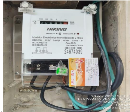
Foto No. 7 y 8 Se realiza cambio de equipo de medida y se deja sistema de medida conforme
