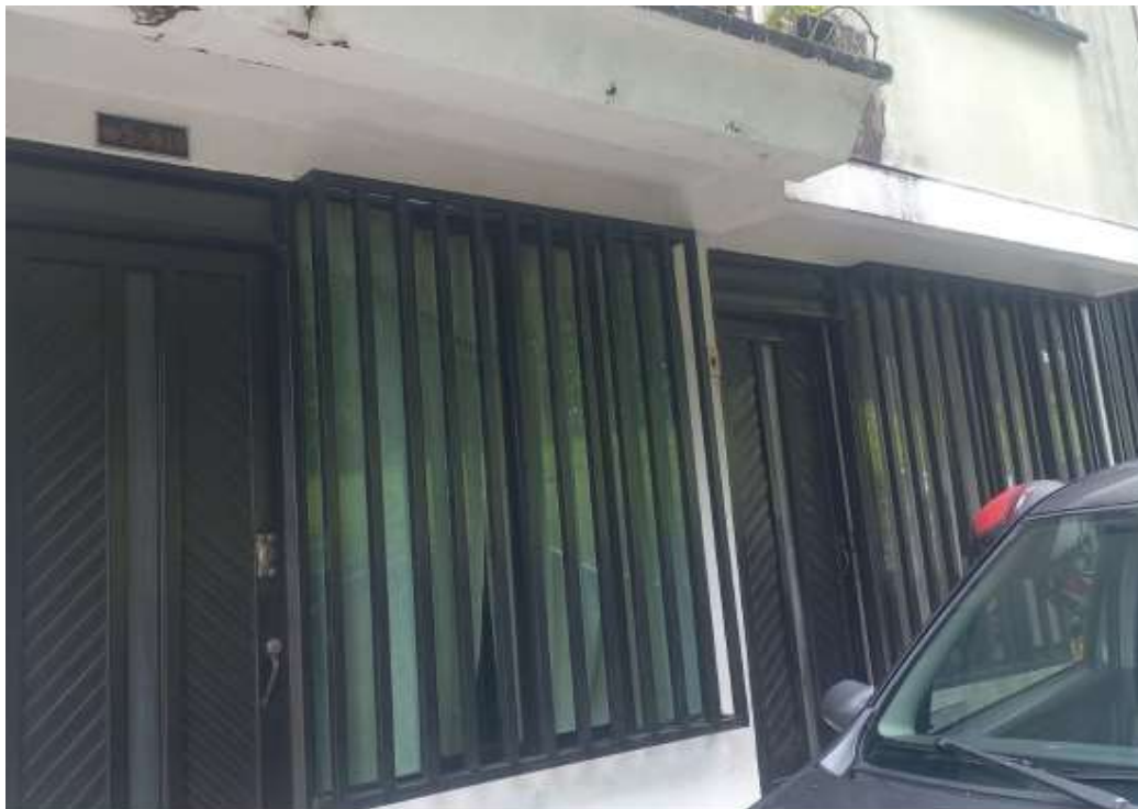
PREDIO EN EL CUAL SON ENTREGADAS LAS FACTURAS:
